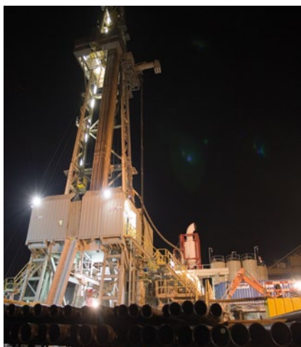
Vue nocturne du rig de forage d'exploitation géothermique à Bâle (photo Basel Geopower AG)
